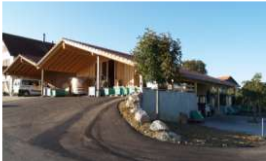
Unser neuer Kelterungskeller mit Sonnenkollektoren auf dem Dach
