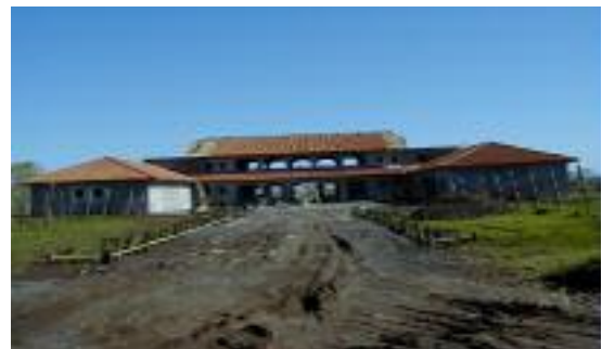
Bodega-Neubau der Vina tierra y fuego
