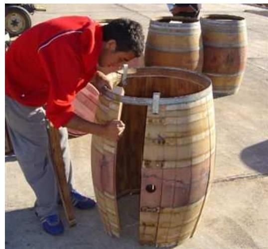
*Zusammensetzen der nummerierten und abgehobelten Fassdauben*
