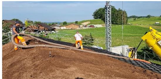
Der Aufbau eines begrüntem Giebedaches ist sicher **komplexer** als der eines Normalen: Es braucht eine wurzelfeste Abdichtung, eine gute Schubsicherung und ein extensiv-organisches Substrat, das mit den extremen Witterungsverhältnissen klar kommt. Gelingt das aber, hat man einiges für den **Klimaschutz** und für **die Biodiversität** getan.
