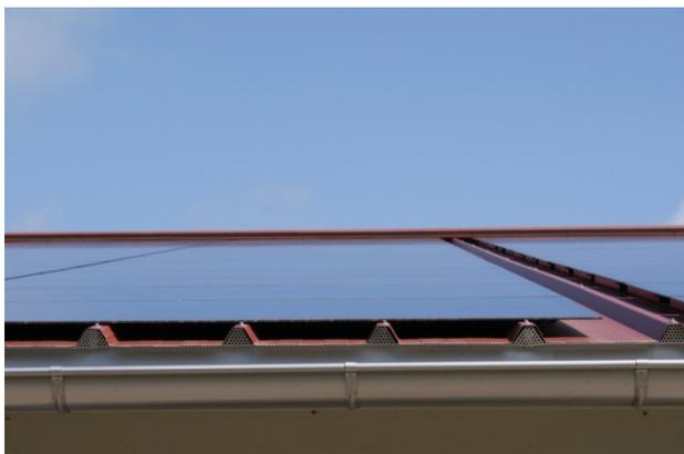
Die Photovoltaik (PV; Abb. 4) verwendet anstelle von normalen PV-Modulen mit Alurahmen, die meist auf einen Leichtmetallträger auf dem Dach montiert werden, rahmenlose Glas-Glas-Lamine, die direkt auf die Trapezprofile der Dachhaut geklebt sind und damit eine energetisch günstige Hinterlüftung der Panele sichern. Rahmenlose Glas-Glas-Lamine haben grössere
